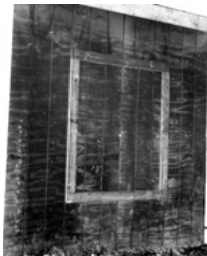
Figura 4. Cuando las llamas no hicieron contacto con la pared, la pared construida a los 10 metros se chamuscó pero no se inflamó.
